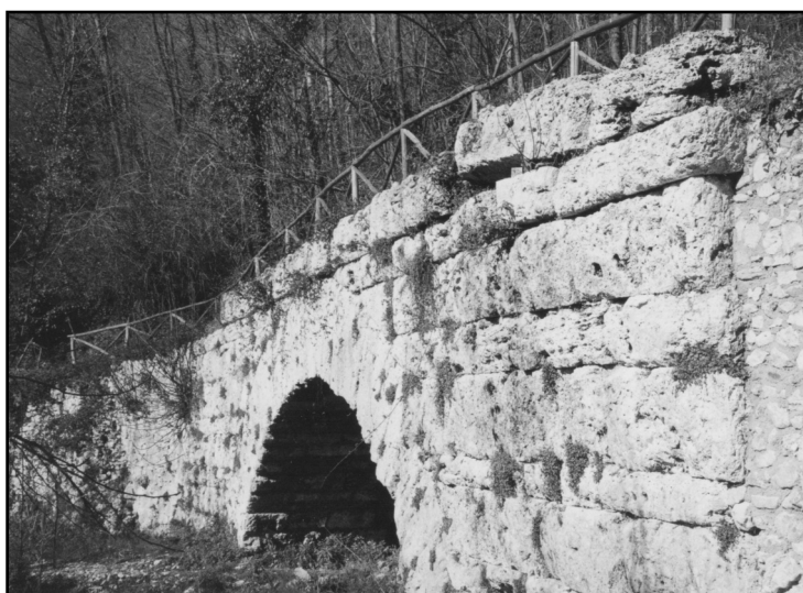
Roviano, Ponte Scotonico durante i recenti restauri.
